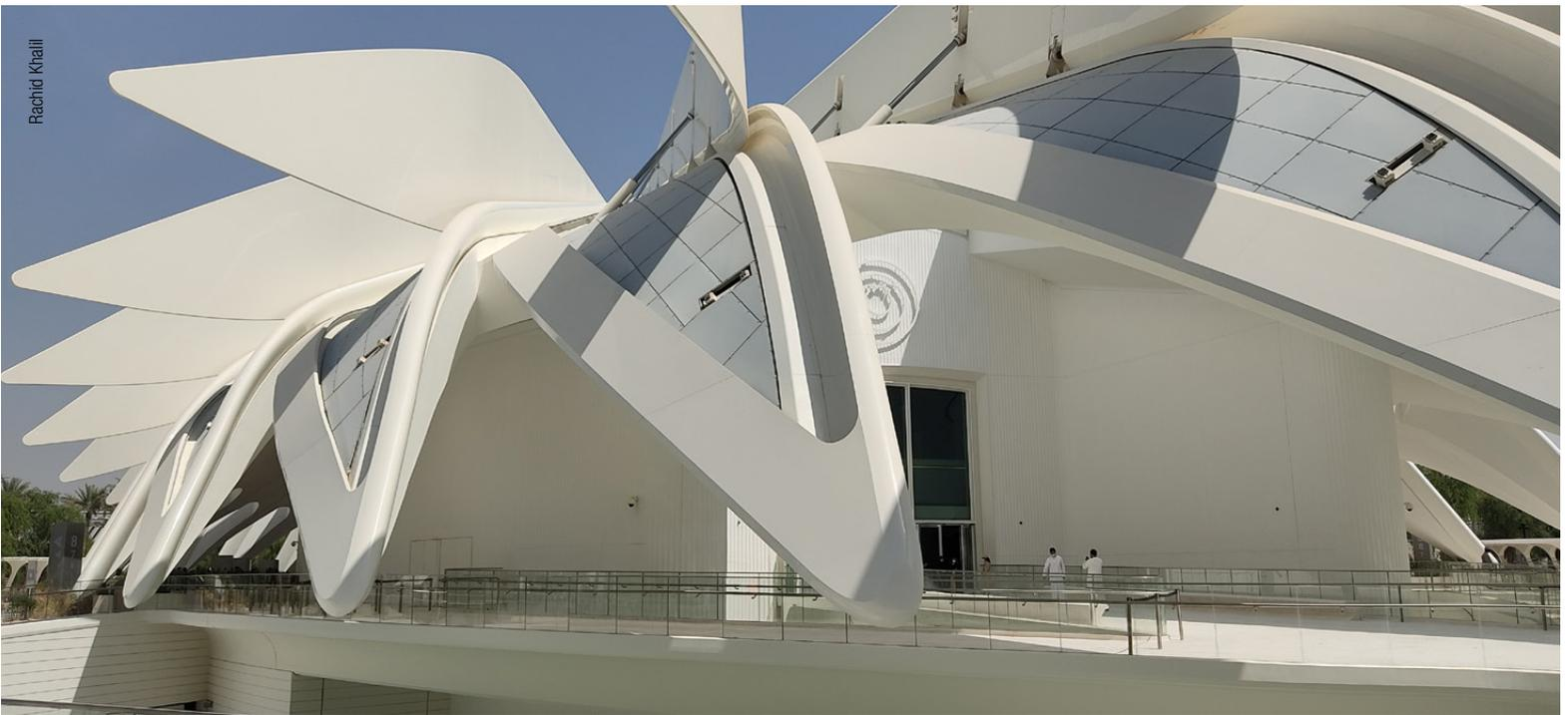
1. struttura primaria a sezione scatolare in piatti d'acciaio saldati di dimensioni variabili
